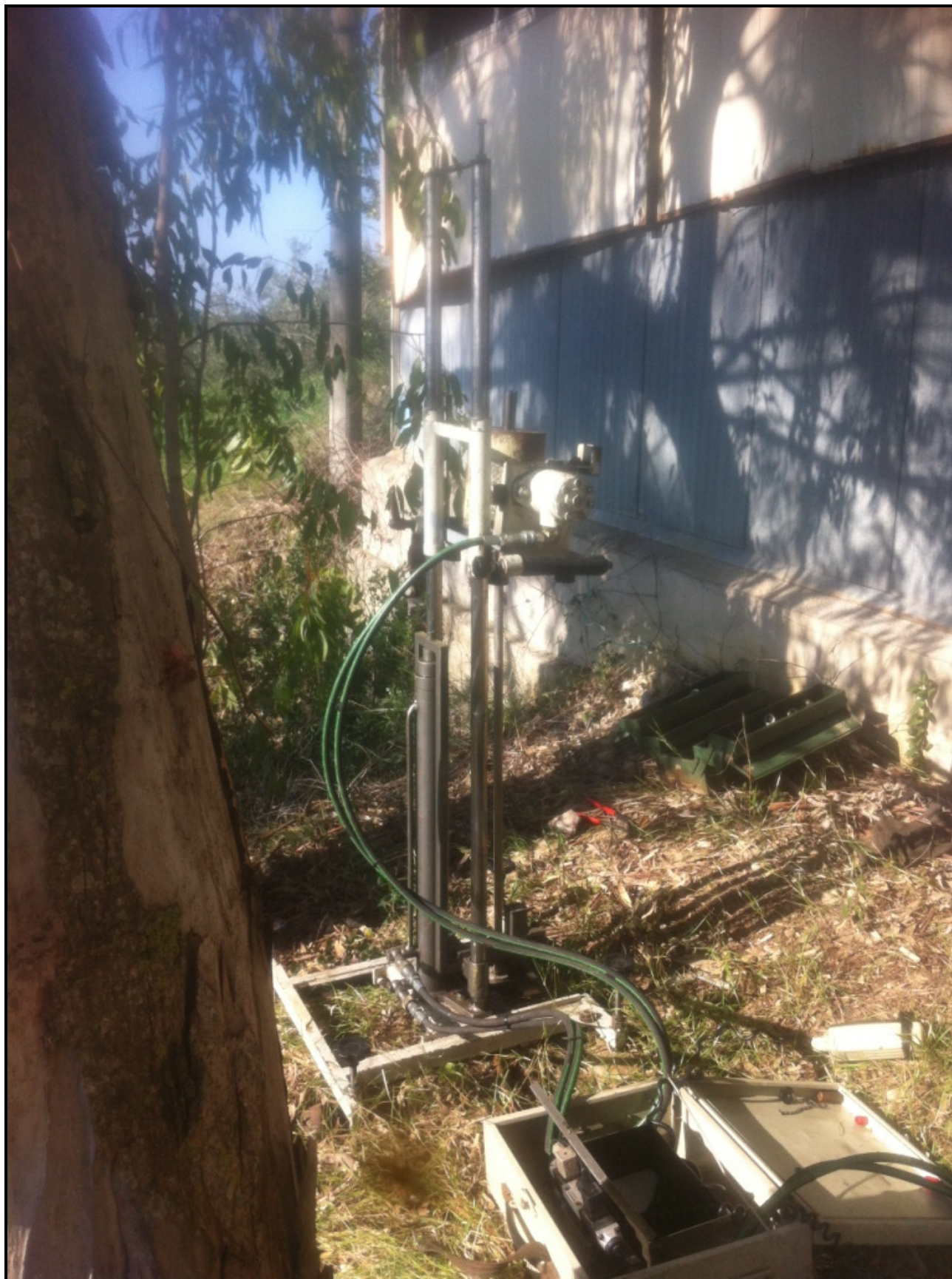
Foto 1: prova penetrometrica P1
